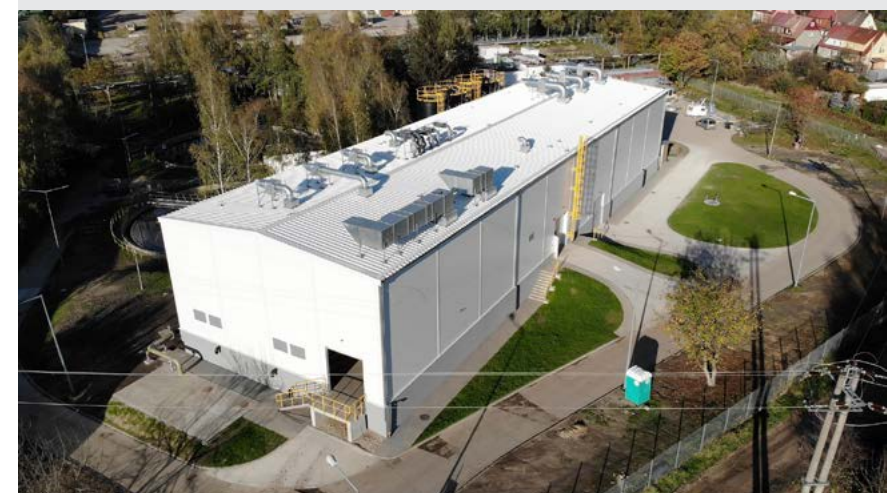
Rozbudowa oczyszczalni ścieków w Elektrowni Turów (SEEN Technologie sp. z o.o.)
