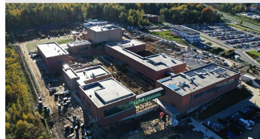
Budowa Świętokrzyskiego Kampusu Laboratoryjnego Głównego Urzędu Miar w Kielcach (ANNA-BUD sp. z o.o.)
