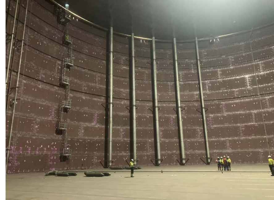
Rozbudowa Terminala LNG w Świnoujściu (PORR S.A.)
