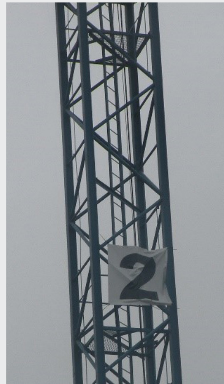
Naprzemiennie usytuowane otwory w pomostach spocznikowych
