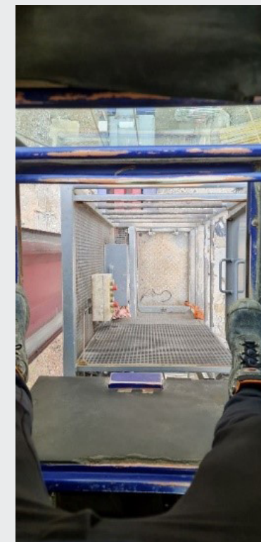
Widok z góry na wieżę
