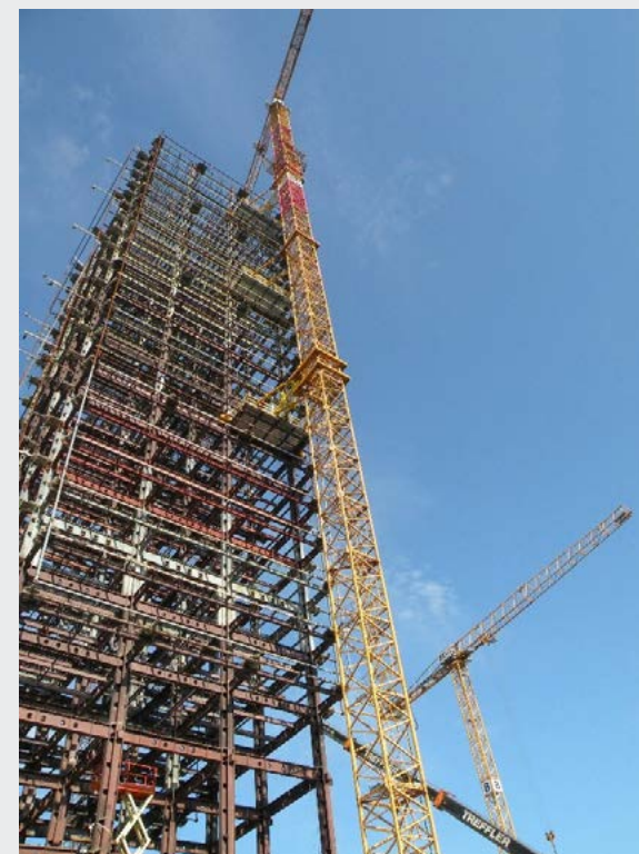
Żuraw wieżowy przed wyposażeniem w windę osobową
