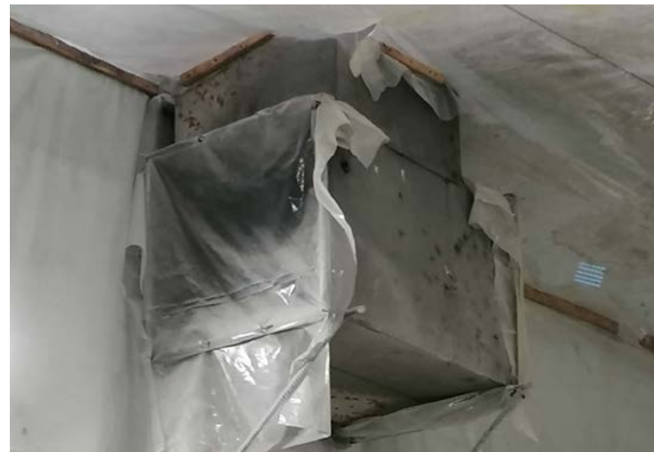
↑ Otwory kanału wentylacyjnego przykryte folią
