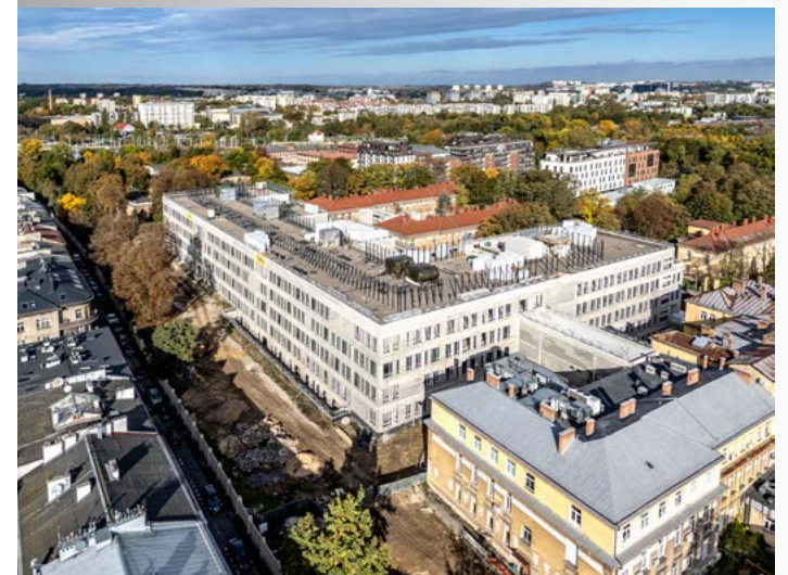
Budowa budynku szpitala w Krakowie (BUDIMEX S.A.)
