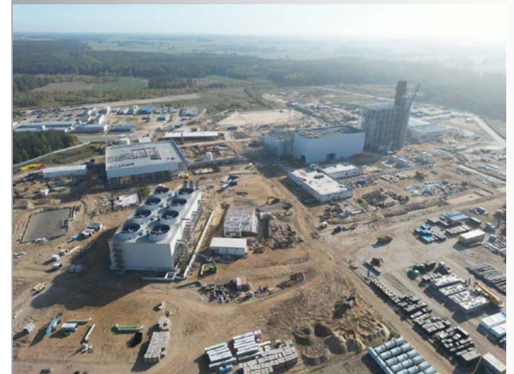
Budowa nowej elektrowni Ostrołęka C (konsorcjum firm: Tecnicas Reunidas S.A. Oddział w Polsce i GE Vernova)
