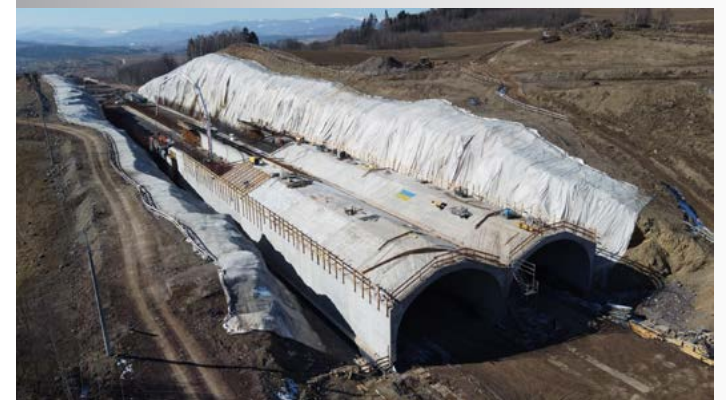
Budowa drogi ekspresowej S-3 Bolków-Kamienna Góra (PORR S.A.)
